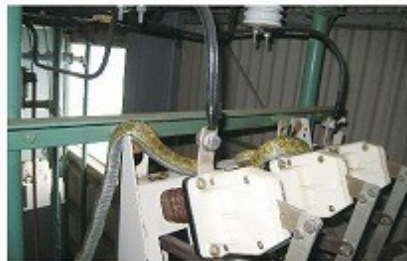
写真1 LBS上部で感電したヘビ
