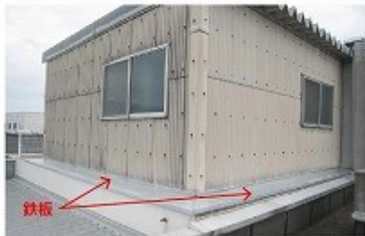
写真2 外壁の隙間への鉄板取付(恒久処置)
